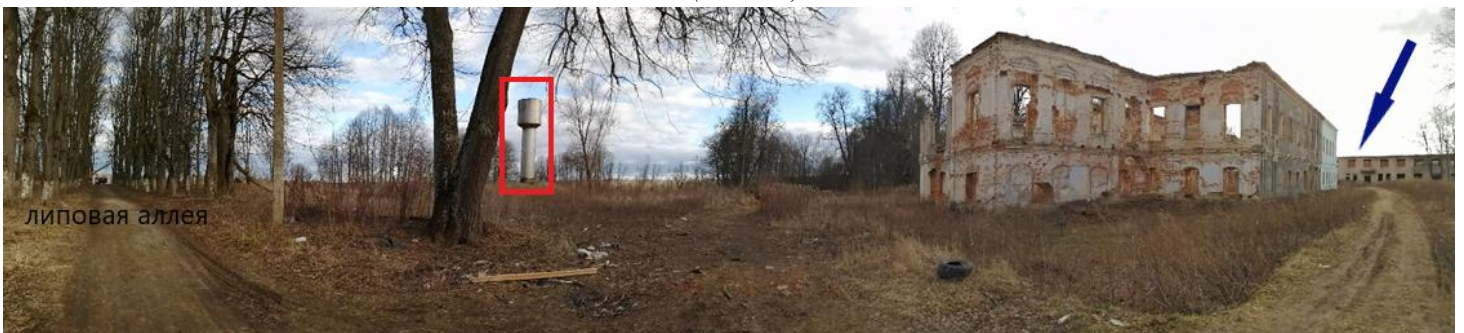
Развертка с точки 6. Красным контуром указано местоположение водонапорной башни; синей стрелкой – местоположение административного двухэтажного здания (1970 г.).
