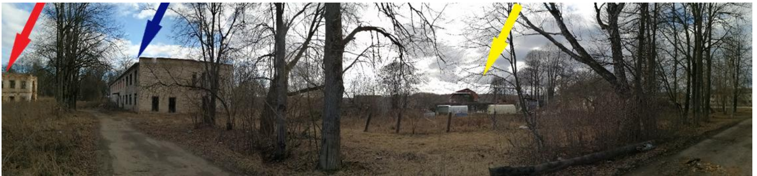
Развертка с точки 11 в западном направлении. Красной стрелкой указан фрагмент главного дома усадьбы; синей стрелкой – местоположение административного двухэтажного здания (1970 г.);
