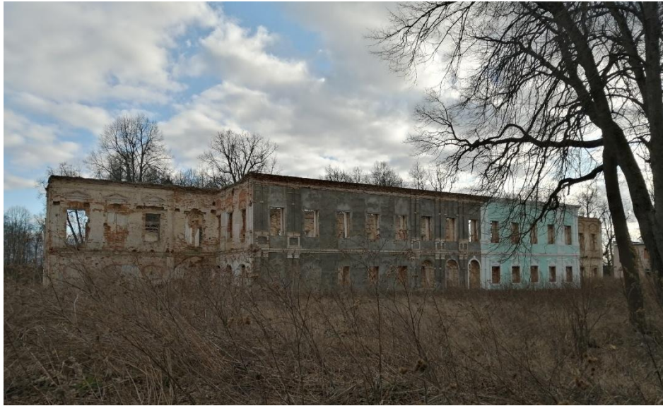
Главный дом. Вид с севера. Фото март 2020 г.
